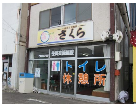
写真1-6 住民交流施設
