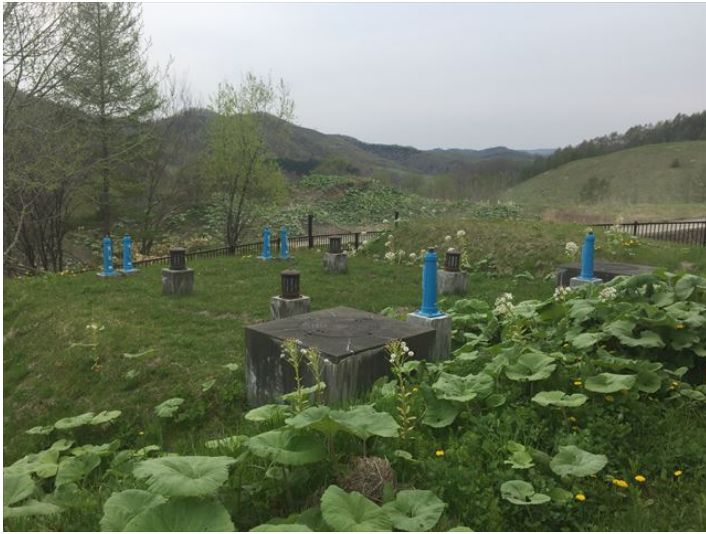
配水池地上部
