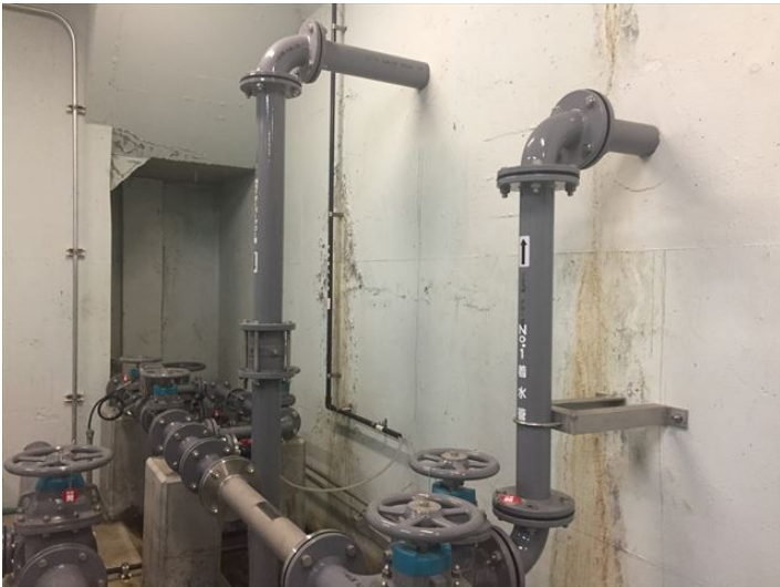
池からの漏水はない
