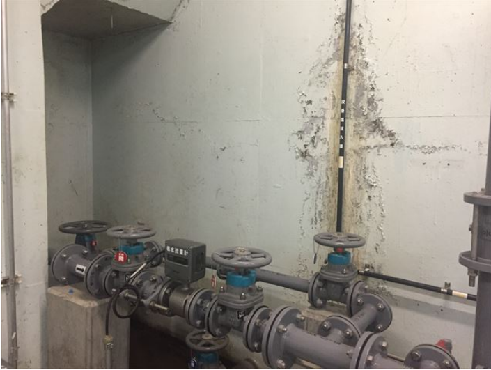
池からの漏水はない
