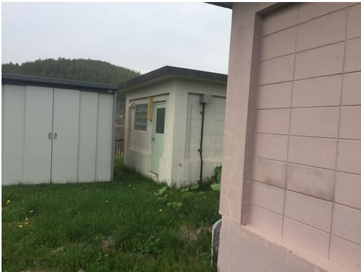
増設ろ過池上屋
