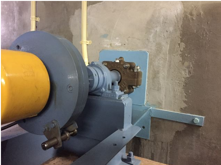
フロキュレータ貫通部
