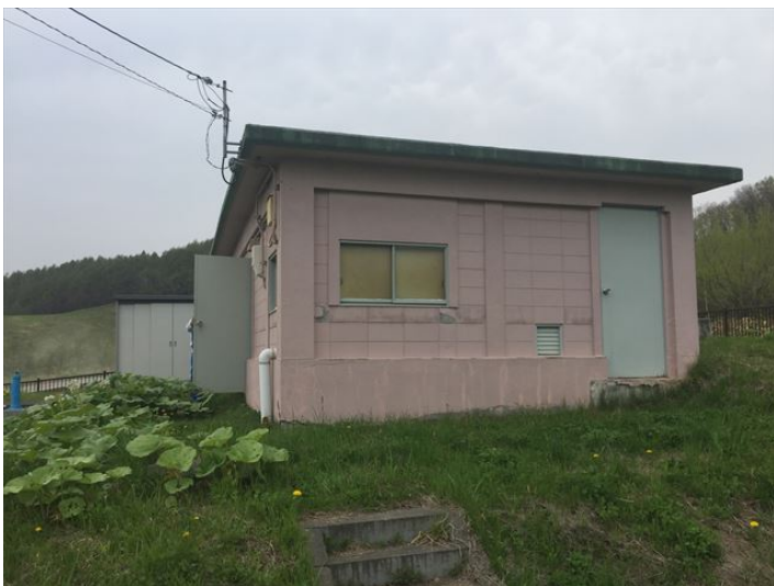
緩速ろ過池上屋
